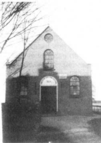
Het kerkgebouw in de 30-er jaren
